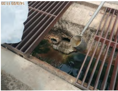
บ่อพักหลังผ่านระบบบำบัดน้ำเสีย ของอาคารที่พักผู้โดยสาร (ชุดที่ 4)
