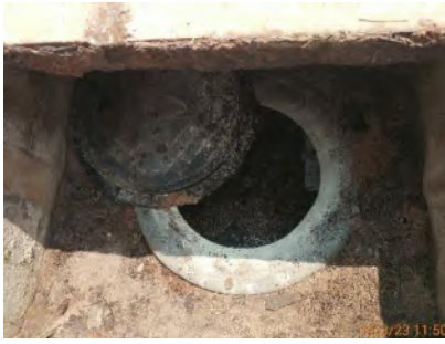
บ่อพักก่อนเข้าสู่ระบบบำบัดน้ำเสีย ของอาคารที่พักผู้โดยสาร (ชุดที่ 4)
