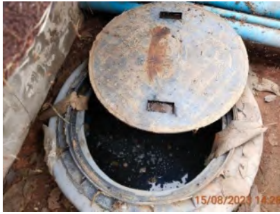
บ่อพักก่อนเข้าสู่ระบบบำบัดน้ำเสีย ของอาคารที่พักผู้โดยสาร ชุดที่ 2
