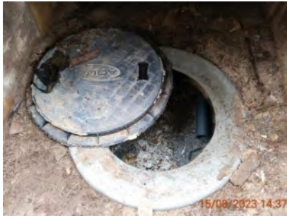
บ่อกักก่อนเข้าสู่ระบบบำบัดน้ำเสีย ของอาคารที่พักผู้โดยสาร ชุดที่ 4
